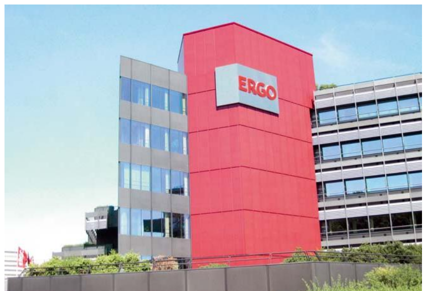
Neue Technik senkt die Kosten für das Gebäude der ERGO-Hauptverwaltung 1 in Hamburg.
